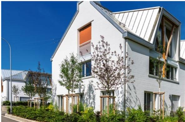
Mit ihrer strahlend weissen Farbe weist die Fassade einen hohen Reflexionsgrad (Albedo-Wert) auf. Dadurch erwärmt sich das Mauerwerk weniger als mit einer dunklen Farbgebung.
