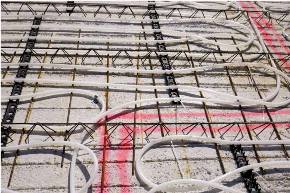
Verlegung Bauteilaktivierung
