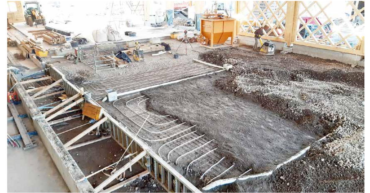
Bauprozess in der bereits aufgerichteten Halle
