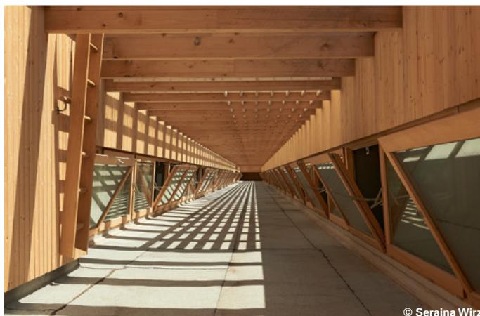
Fensterlügel-Korridor: Blick in den begehbaren Lüftungsschacht ausserhalb der thermischen Gebäudehülle.
