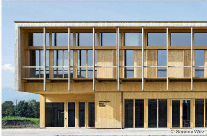
Das obere Fensterband wird durch die Auskragung des Laubengangs verschattet. Vor den unteren, hohen Fenstern sind Holzschiebläden angebracht.
