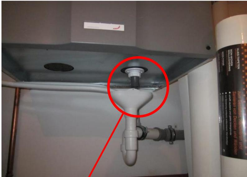
Der offene Kondensatablauf zieht viel Raumluft an, die direkt ausgeblasen wird
