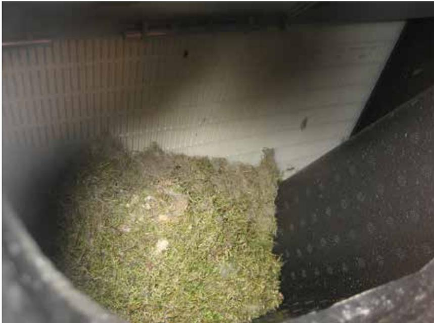
Vogelnest im Lüftungsgerät wegen fehlendem Aussenluftgitter
