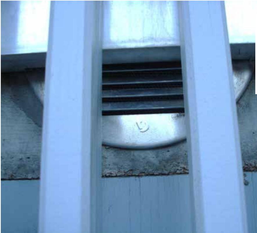
Der Querschnitt des AUL-Kanals genügt nicht; Geschwindigkeit im Gitter max. ca. 2m/s. Sonst wird es verstopfen
