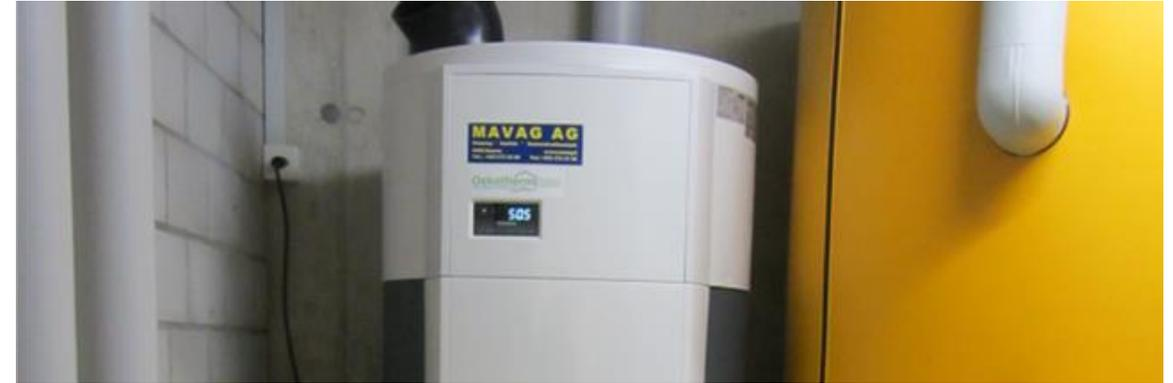
**Zentrale direkt-elektrische Wassererwärmer**
